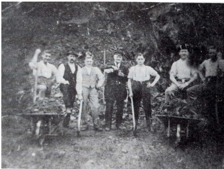
Platzarbeiten auf dem Jahnplatz 1908
